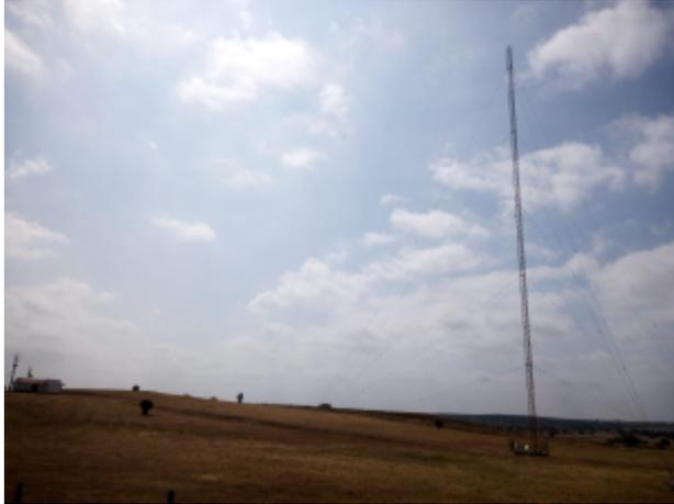
Centro emissor da Antena 1 em Elvas (720 kHz), com a potência de 10 kW. Casa do emissor à esquerda e antena radiante à direita.
